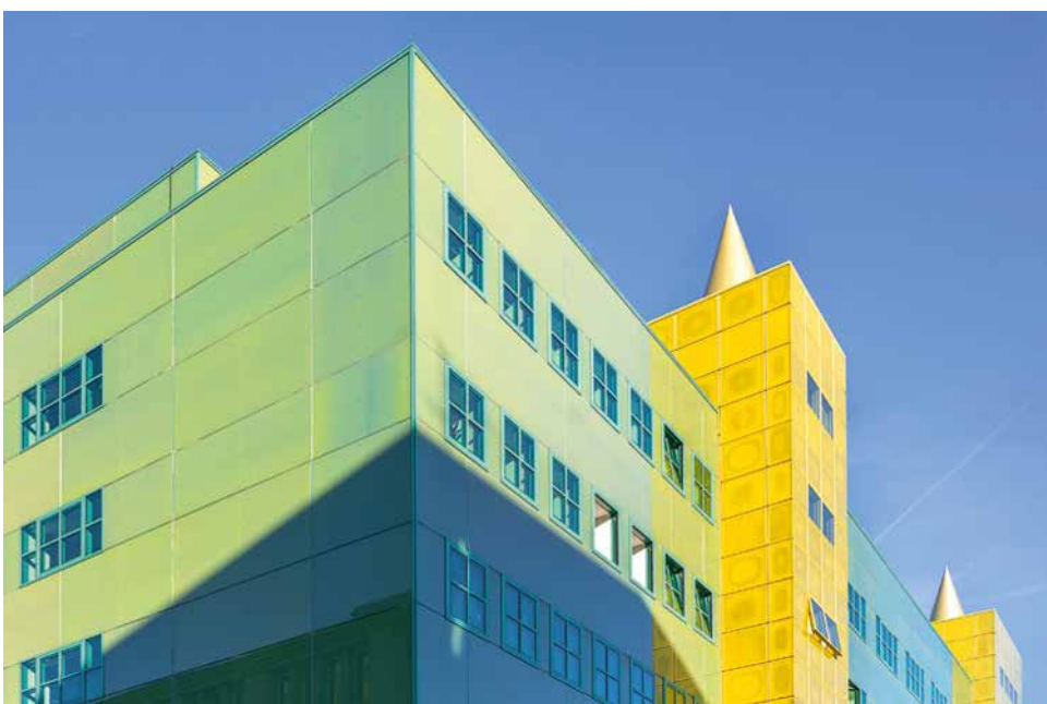
Ansicht des Mendini-Gebäudes. Sitz des DZHW Hannover, Bild: Nölle/DZHW
